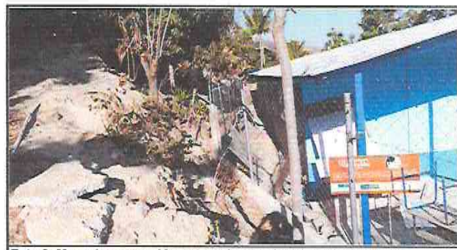
Foto 6: Muro de contención soterrado por el desvanecimiento del barranco, a punto de soterrar las aulas del centro educativo.
