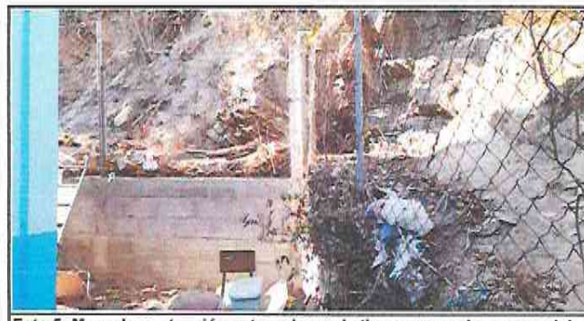
Foto 5: Muro de contención soterrado por la tierra que se desvanece del barranco.
