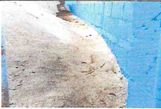
Foto 1: Reparación de cuneta de concreto
