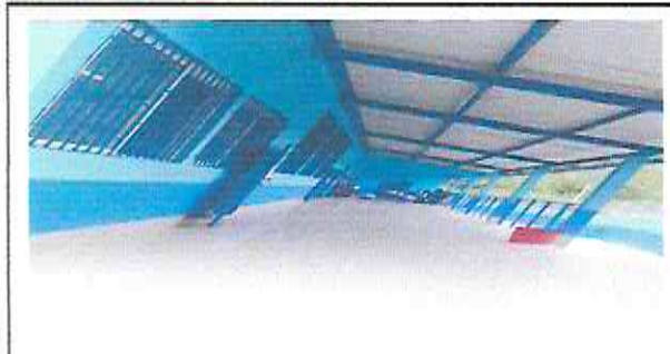
Foto 9: Pinturas en muro interior y exterior
