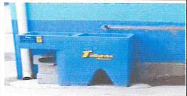
Foto 4: Instalación de pila
