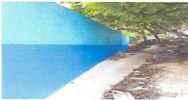
Foto 3: Reparación de muro de contención
