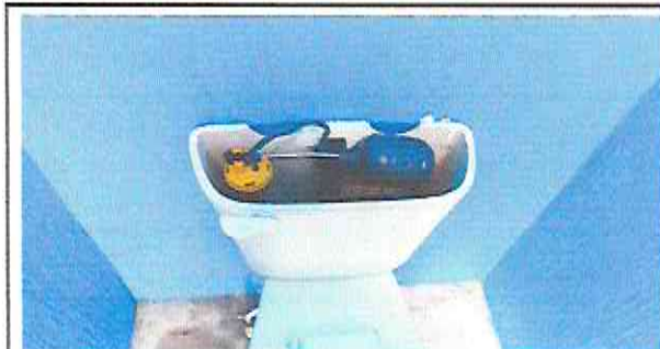
Foto 10: Sustitución de accesorios de inodoro
