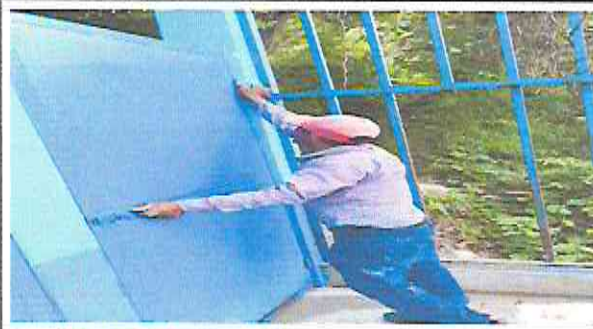
Foto 8: Mantenimiento de estructura
