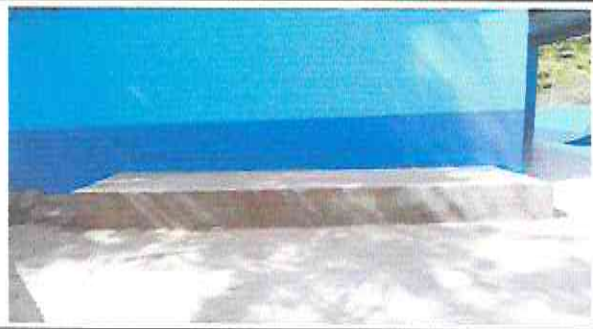
Foto 9: Pinturas en muro interior y exterior
