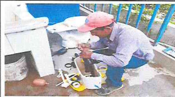
Foto 10: Sustitución de accesorios
