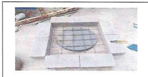
Foto 6: Mantenimiento de reposaderas
