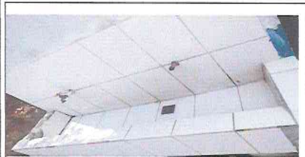
Foto 5: Instalación de Chorros
