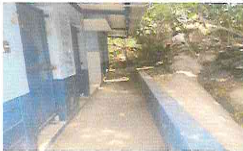
Foto 3: Reparación de muro de contención
