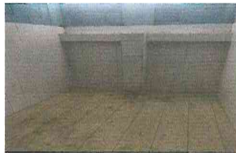
Foto 4: Instalación de pila
