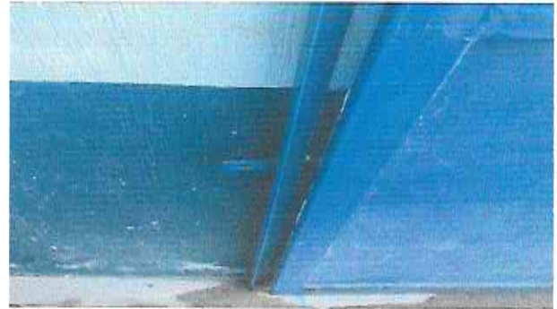
Foto 8: Mantenimiento de estructura
