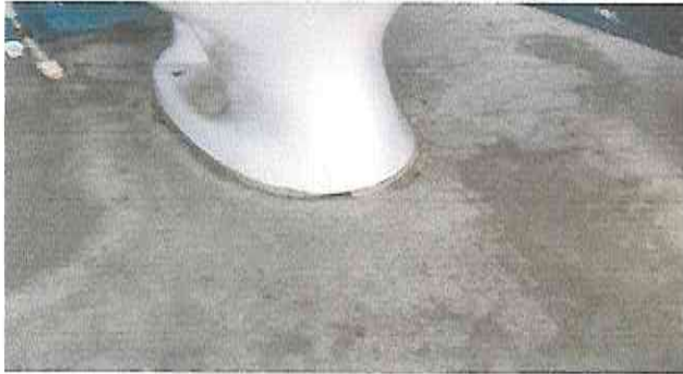
Foto 7: Reparacion de letrina
