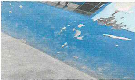
Foto 9: Pinturas en muro interior y exterior
