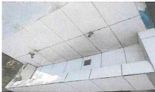
Foto 5: Instalación de Chorros
