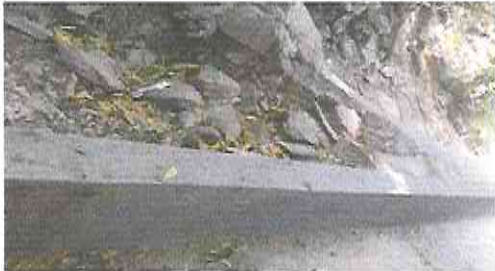
Foto 1: Reparación de cuneta de concreto
