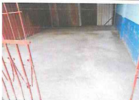
Foto 3: Fundición de torta de cemento en galera
