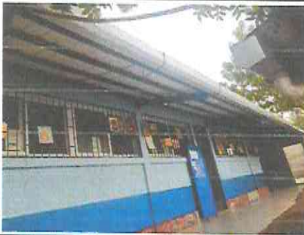
Foto 11: Cambio de canal pvc
