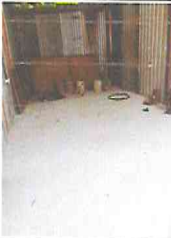
Foto 9: Fundición de torta de cemento en galera.
