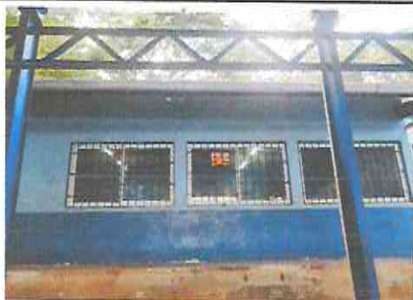
Foto 5: Cambio de canal pvc
