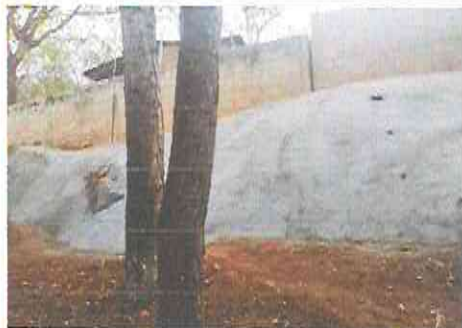
Foto 1: Protección de muro existente.
