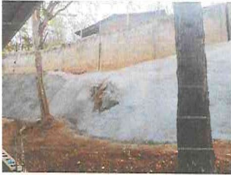
Foto 7: Protección de muro existente.
