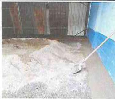
Foto 9: Fundición de torta de cemento en galera.
