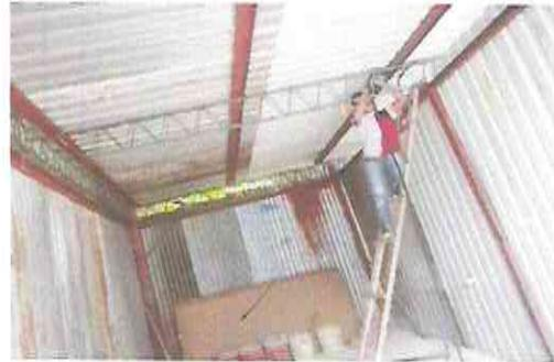
Foto 4: Sustitución de cable eléctrico en galera
