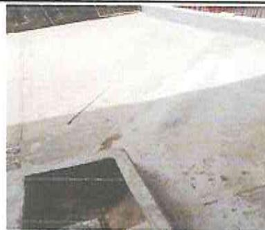
Foto 6: Instalación de tubería para salida de agua pluvial
