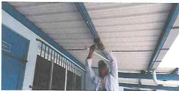
Foto 5: Sustitución de plafoneras y bombillas en todas las áreas a intervenir
