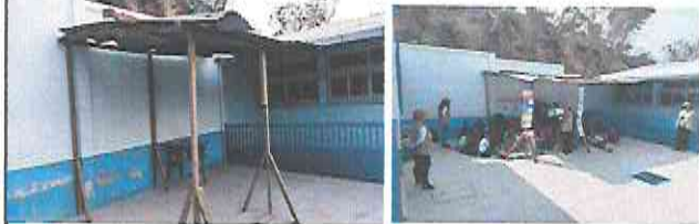
FOTO 4: Sustitución de lámina por lámina troquelada aluzinc, calibre 26, estructura de metal con viga tipo joys, en toda el área, que se logra apreciar en la segunda imagen.
