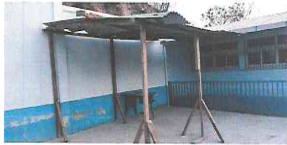
FOTO 8: Sustitución de lamina, por lamina troqueada de aluzinc calibre 26, en cocina.
