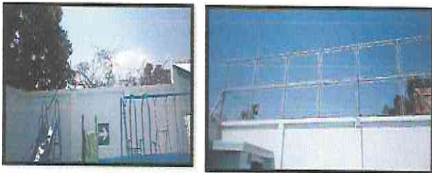
Continuación de instalación de malla metálica galvanizada, con tubo hg redondo y soleras, como la que se vé en la imagen.
