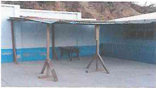
FOTO 7: Elaboración de estructura metálica tipo jois para cocina,
