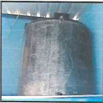
FOTO 3: Sustitución de rotoplas de 1700 litros, debido a que el que está se encuentra roto
