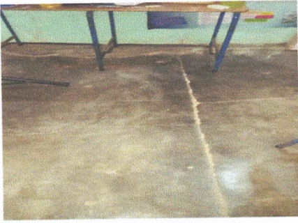
Foto 1: Reparación de piso liquido por torta de cemento en la dirección del establecimiento.
