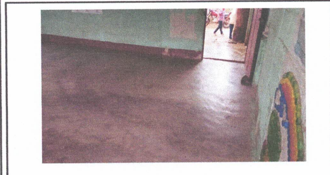
foto3: Reparación de piso líquido por torta de concreto en aula no.3
