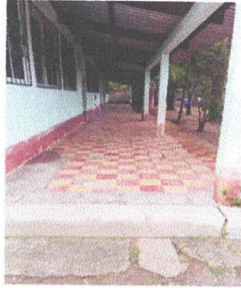
Foto1: Reparación de piso liquido por torta de concreto en el corredor
