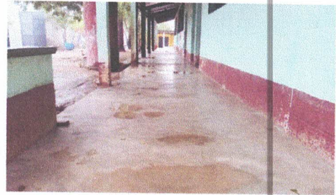
Foto 2: Reparación de piso liquido por torta de concreto en el corredor
