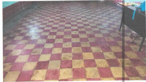
Foto 4: Reparación de piso líquido por torta de cemento c en aula no.1
