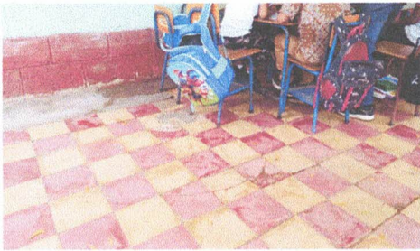
Foto1: Reparación de piso liquido por torta de concreto en el corredor
