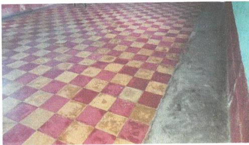
Foto 3: Reparación de piso líquido por torta de concreto en aula no.1
