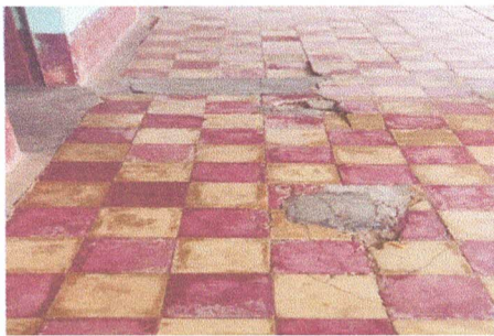
Foto 5: Reparación de piso liquido por torta de concreto en el corredor
