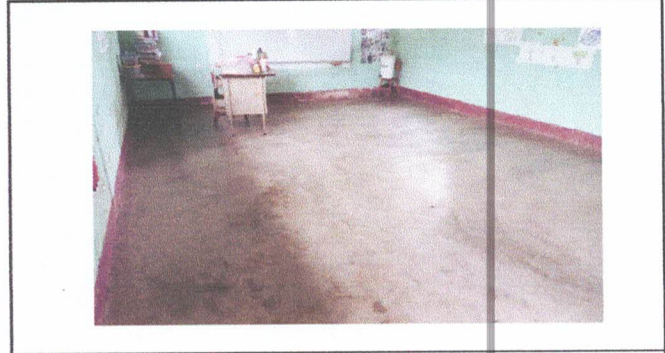
Foto 2: Reparación de piso líquido por torta de concreto en aula no.3
