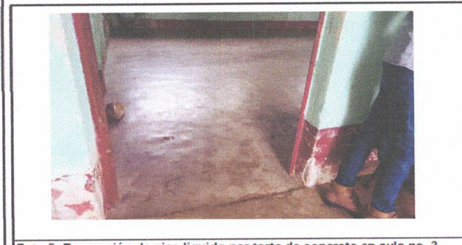
Foto 5: Reparación de piso líquido por torta de concreto en aula no. 3
