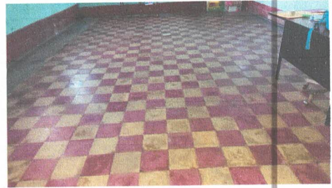
Foto 2: Reparación de piso líquido por torta de concreto en aula no.1
