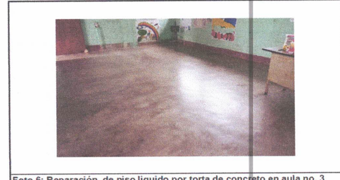
Foto 6: Reparación de piso líquido por torta de concreto en aula no. 3
