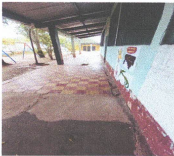
Foto 5: Reparación de piso liquido por torta de concreto en el corredor
