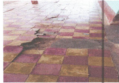
Foto 2: Reparación de piso liquido por torta de concreto en el corredor
