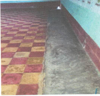
Foto 1: Reparación de piso líquido por torta de concreto en aula no.1
