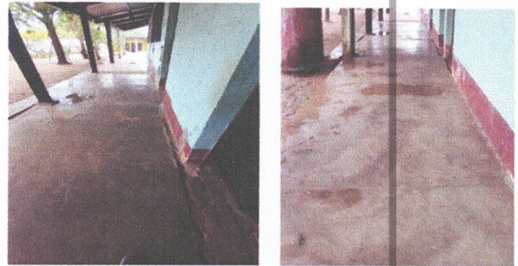
Foto 6: Reparación de piso liquido por torta de concreto en el corredor
