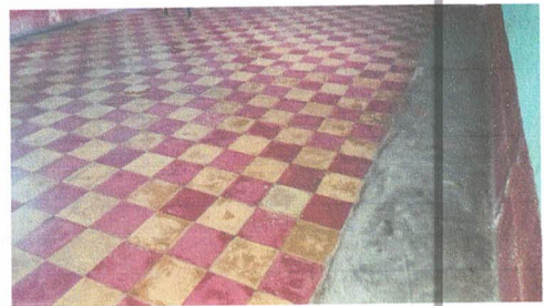
Foto 6: Reparación piso líquido por torta de concreto en aula no.1
