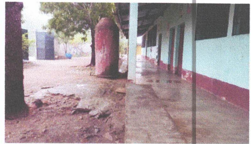
Foto 4: Reparación de piso liquido por torta de concreto en el corredor
