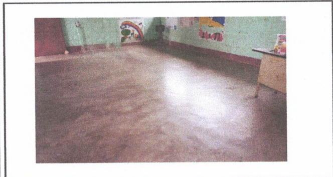
Foto1: Reparación de piso líquido por torta de concreto en aula no. 3
