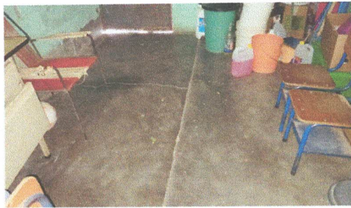
Foto 3: Reparación de piso liquido por torta de concreto en dirección del establecimiento.
