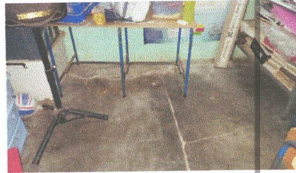
Foto 2: Reparación de piso liquido por torta de concreto en dirección del establecimiento.
