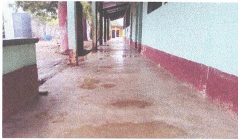
Foto 3: Reparación de piso liquido por torta de concreto en el corredor
