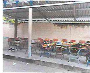
Foto 14: Sustitución de lámina troquelada calibre 26 aluzinc en galera que funciona como aula.
