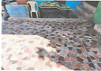
Foto 13: Instalación de piso antideslizante en corredor de cocina.
