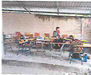
Foto 15: Sustitución de estructura de soporte de metal en galera que sirve como aula.
