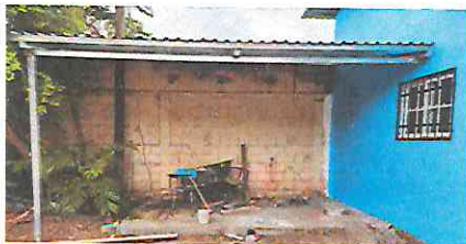
Foto 17: Sustitución de estructura de soporte en galera que sirve como bodega.
