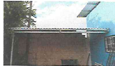
Foto 16: Sustitución de lámina troquelada calibre 26 aluzinc en galera que sirve como bodega.
