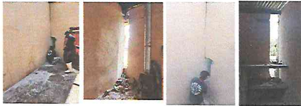
Foto1: Reforzamiento de muro en cocina.
