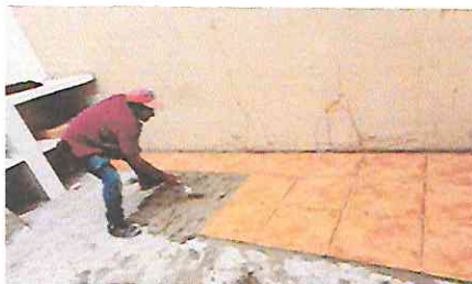
Foto 5: Sustitución de piso cerámico en cocina
