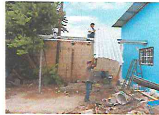
Foto 16: Sustitución de lámina troquelada calibre 26 Aluzinc en galera que sirve como bodega.
