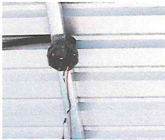
Foto 9: Sustitución de iluminatorias; incluye bombilla, cable, flexitubo y plafonera en cocina.
