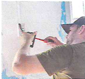
Foto 11: Sustitución de apagadores; incluye cable, flexitubo, tubo y apagador en la cocina.
