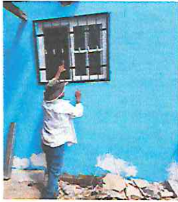
Foto7: Área donde se instaló el balcón de metal en cocina .
