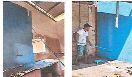
Foto 12: Pintura en muros exteriores e interiores en la cocina
