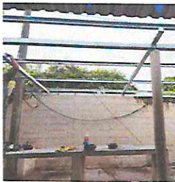
Foto 15: Sustitución de estructura de soporte de metal en galera que sirve como aula.
