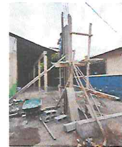
Foto 4: Sustitución de estructura de metal de soporte en corredor de cocina
