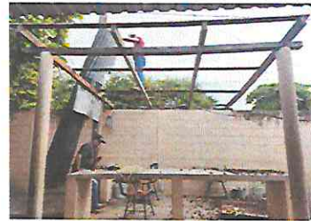
Foto 14: Sustitución de lámina troquelada calibre 26 aluzinc en galera que funciona como aula.
