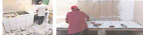
Foto 8: Instalación de azulejo en cocina
