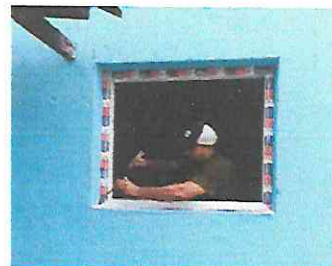
Foto 6: Sustitución de ventana PVC en cocina
