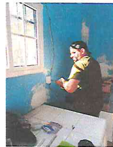
Foto 10: Sustitución de toma fuerza; incluye tomacorriente, cable, flexitubo y caja en la cocina.
