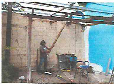
Foto 17: Sustitución de estructura de soporte en galera que sirve como bodega.
