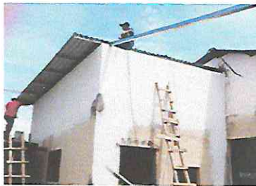
Foto 3: Sustitución de lámina troquelada de aluzinc calibre 26 en cocina
