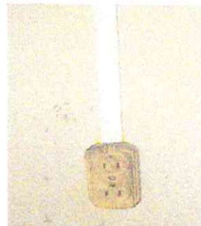
Foto 10: Sustitución de tomafuerza; incluye tomacorriente, cable, flexitubo y caja en la cocina.
