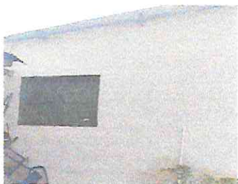
Foto 7: Área donde se instalará el balcon de metal en la cocina.
