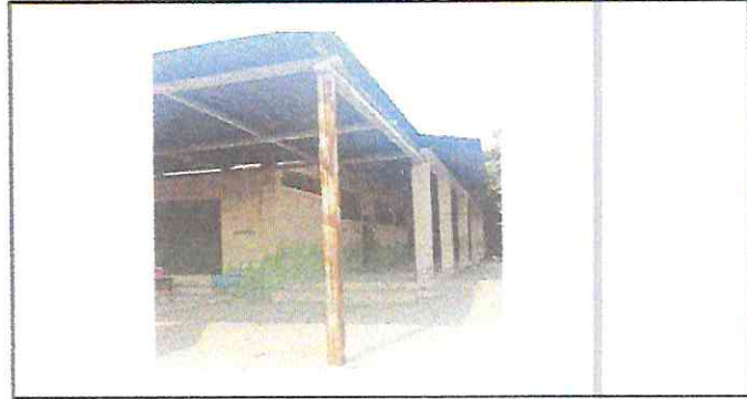
Foto 4: Sustitucion de estructura de metal de soporte en corredor de cocina.
