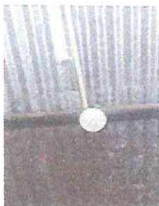
Foto 9: suatitución de iluminarias; incluye bombilla, cable, flexitubo y plafonera en la cocina.
