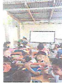
Foto 14: Sustitución de lámina troquelada calibre 26 Aluzinc en galera que funciona como aula.
