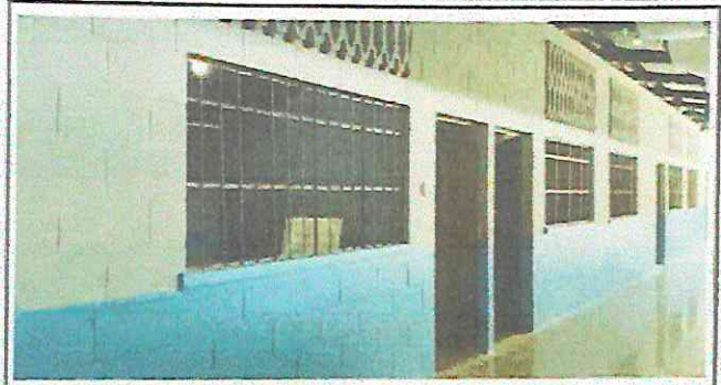
Foto 1: Pintura en muros exteriores e interiores
