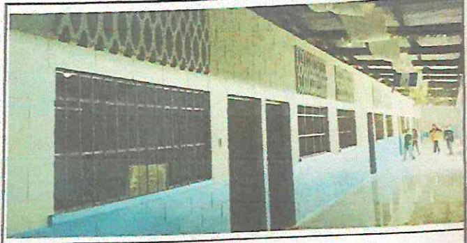
Foto 2: Pintura en muros exteriores e interiores
