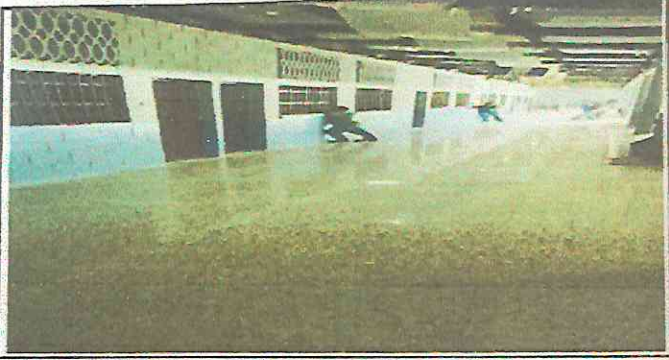
Foto 4: Sustitución de piso de granito
