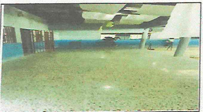
Foto 3: Sustitución de piso de granito
