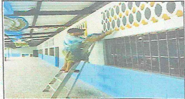
Foto 2: Pintura en muros exteriores e interiores
