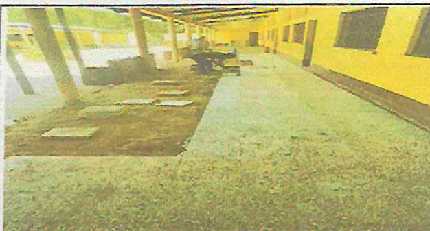
Foto 5: Sustitución de piso de granito
