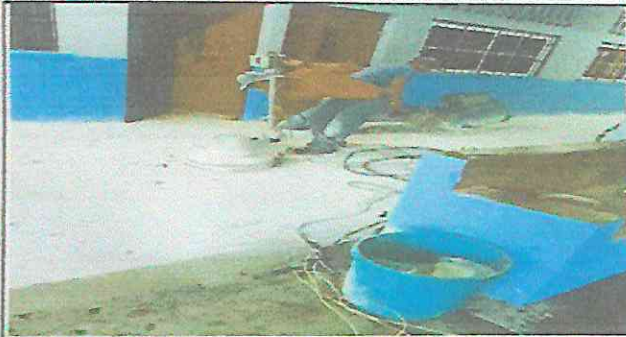
Foto 3: Sustitución de piso de granito
