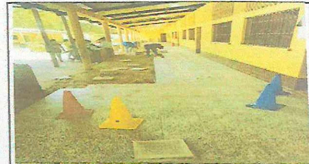
Foto 4: Sustitución de piso de granito
