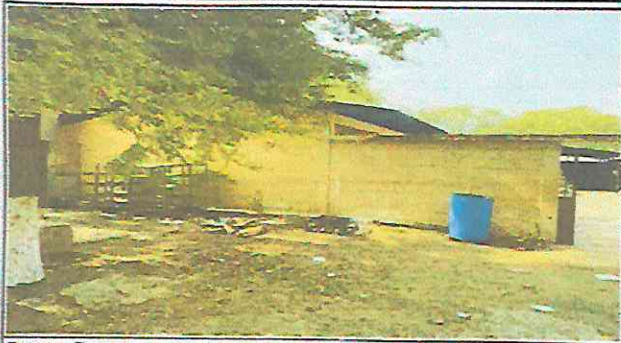
Foto1: Pintura en muros exteriores e interiores
