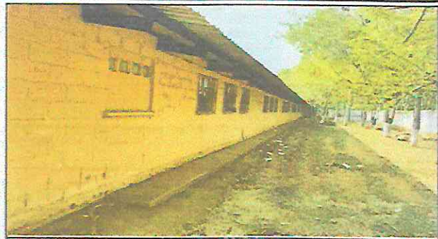
Foto 2: Pintura en muros exteriores e interiores
