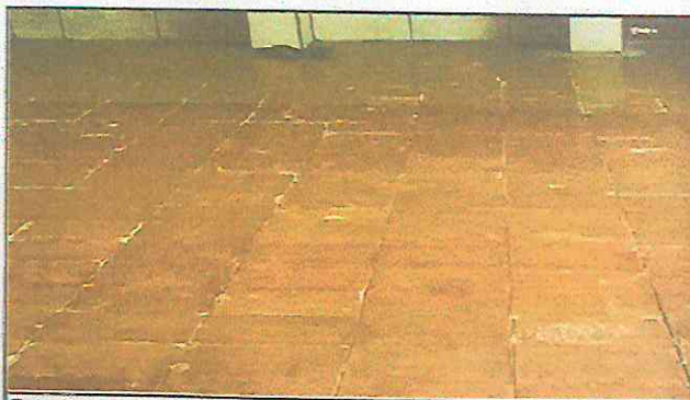
Foto 6: Sustitución de piso de granito
