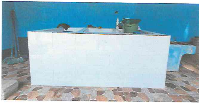
Sustitución de pila de cemento de dos lavaderos pequeña por pila de cemento de dos lavaderos grande con azulejo.
