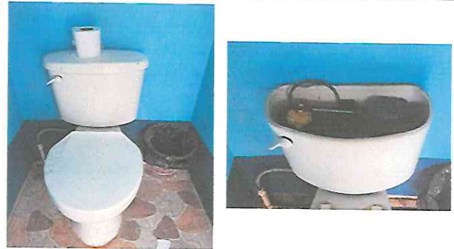
Sustitución de accesorios de sanitarios.
