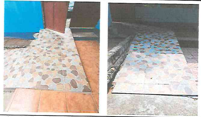
Sustitución de gradas por rampa de ingreso
