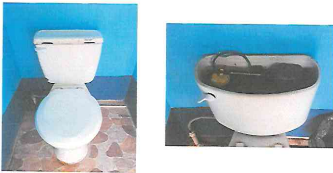
Sustitución de accesorios de sanitarios.
