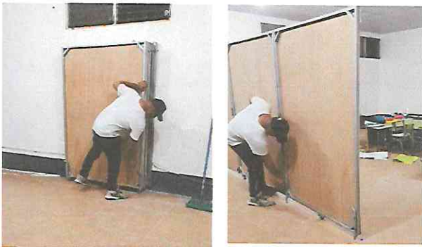
Ampliación de división de aula.
