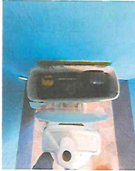
Sustitución de accesorios de sanitarios.
