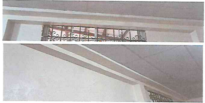
Sustitución de canal.
