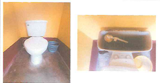
Sustitución de accesorios de sanitarios.
