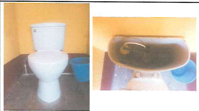
Sustitución de accesorios de sanitarios.
