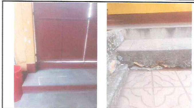
Sustitución de gradas por rampa de ingreso
