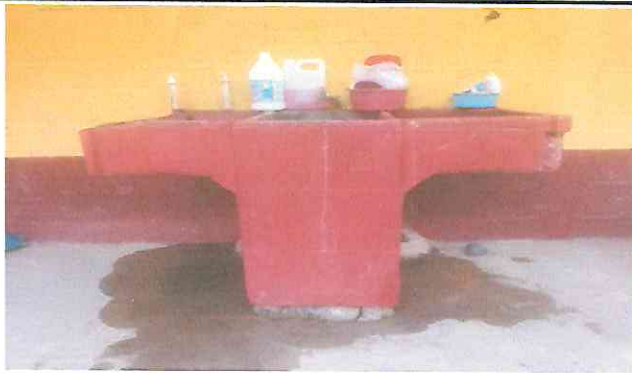
Sustitución de pila de cemento de dos lavaderos pequeña por pila de cemento de dos lavaderos grande con azulejo.
