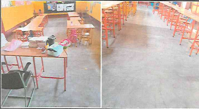
Sustitución de piso de torta de concreto por piso cerámico
