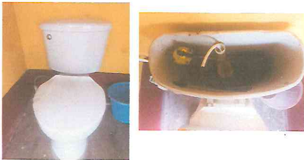
Sustitución de accesorios de sanitarios.
