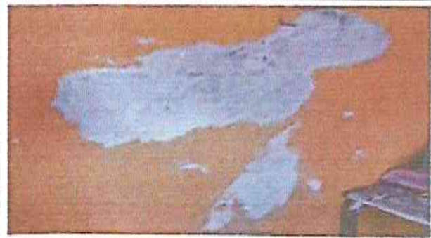
Foto 2: Sustitución de cemento en aula
