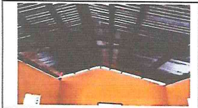
Foto 9: Sustitución de techo en aula
