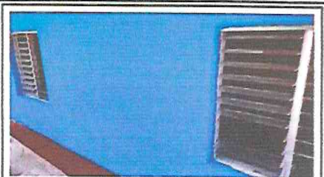
Foto 8: Colocación de balcones
