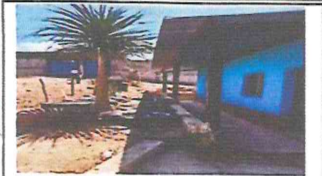
Foto 7: Meter bajada de agua del canal del aula a la cuneta
