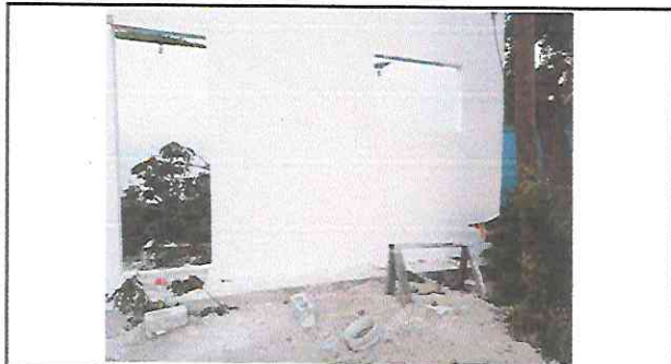
Foto 3: Finalización de la reparación de repello y cernido.
