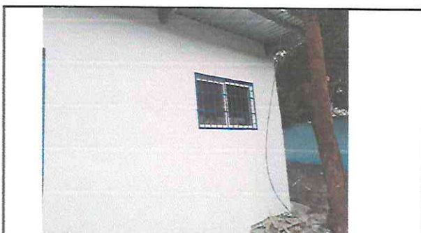
Foto 4: Finalización de sustitución de Balcones y Ventanas.
