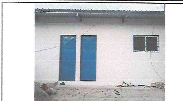
Foto 2: Terminación de sustitución de puertas.
