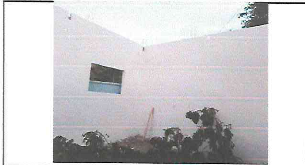
Foto 1: Teminación de continuación de paredes de aula.
