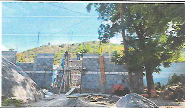
Foto 3: Continuación de paredes de aula.
