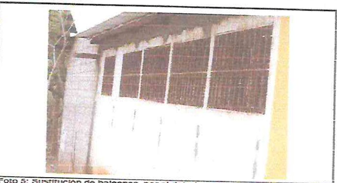
Foto 5: Sustitución de balcones, por el deterioro de los mismos.
