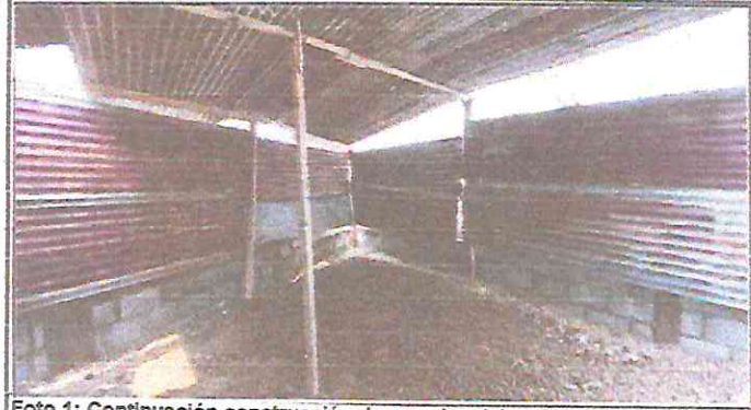
Foto 1: Continuación construcción de paredes del aula.
