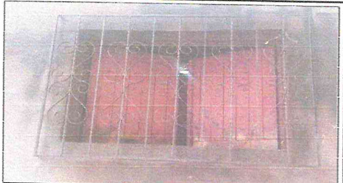
Foto 2: Sustitución de ventanas de madera por metal mas vidrio.
