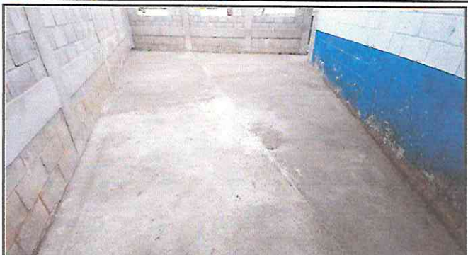
Foto 2: Sustitución de torta de concreto, en el aula.
