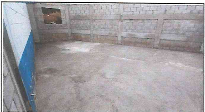
Foto 4: Sustitución de torta de concreto, en el aula.
