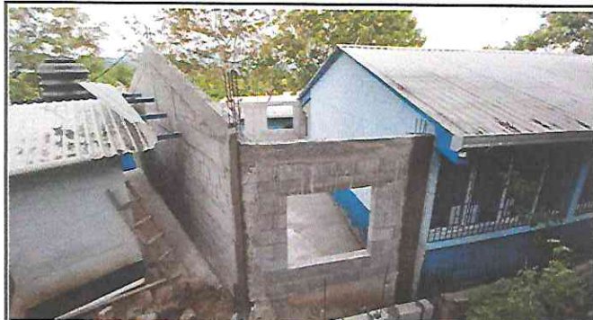
Foto 3: Sustitución cerramiento de lámina por muro de mampostería reforzada.
