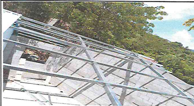
Foto 3: Sustrucción de estructura de soporte de madera, por metal en el aula.
