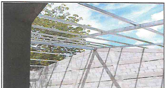
Foto 4: Sustrucción de estructura de soporte de madera, por metal en el aula.
