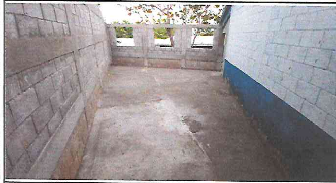
Foto 3: Sustitución de torta de concreto, en el aula.
