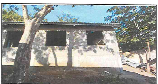
Foto 6: Sustitución de lámina por lámina troquelada aluzinc calibre 26 con tornillera de fijación, en el aula.
