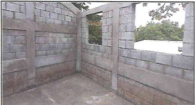
Foto 2: Sustitución cerramiento de lámina por muro de mampostería reforzada.
