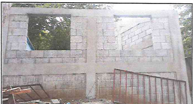
Foto 4: Sustitución cerramiento de lámina por muro de mampostería reforzada.
