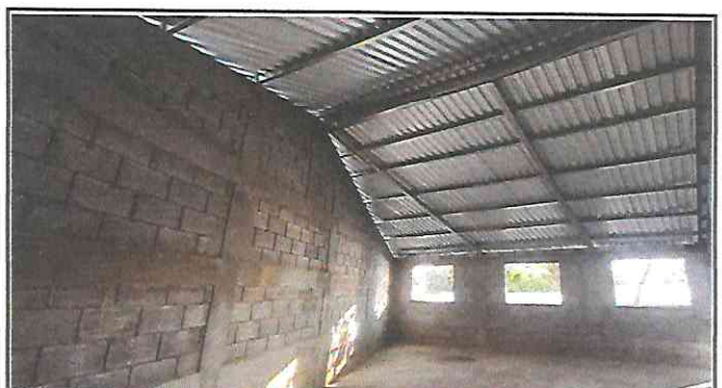
Foto 4: Sustitución de lámina por lámina troquelada aluzinc calibre 26 con tornillera de fijación, en el aula.
