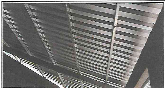
Foto 2: Sustitución de lámina por lámina troquelada aluzinc calibre 26 con tornillera de fijación, en el aula.
