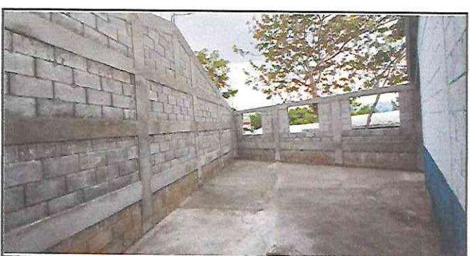
Foto 6: Sustitución de torta de concreto, en el aula.
