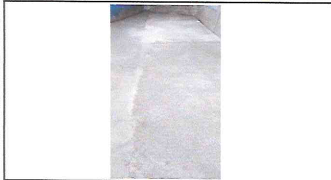
Foto 1: Sustitución de torta de concreto, en el aula.
