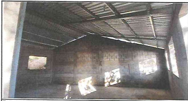
Foto 5: Sustitución cerramiento de lámina por muro de mampostería reforzada.
