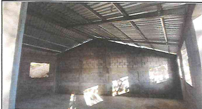
Foto 3: Sustitución de lámina por lámina troquelada aluzinc calibre 26 con tornillera de fijación, en el aula.
