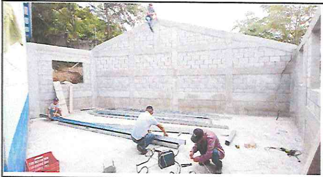
Foto 3: Herrero midiendo las costaneras galvanizadas para su instalación, para sustituir la estructura de soporte de madera por metal, en el aula.
