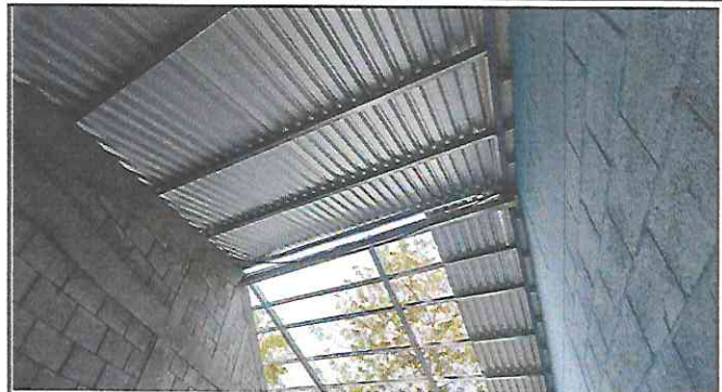
Foto 2: Sustitución de lámina en el aula.
