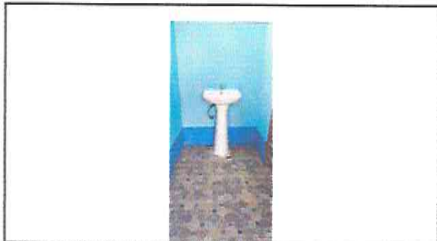
Foto 3: Finalización de Sustitución de lavamanos con sus respectivos accesorios
