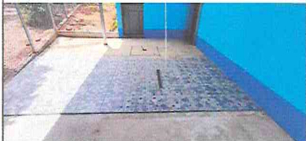
Foto 5: Finalización de instalación de piso cerámico en el área de pila.
