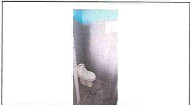
Foto 2: Finalización de colocar azulejo en baño.
