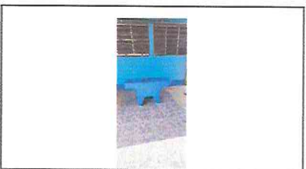
Foto 6: Compra e instalación de pila plástica
