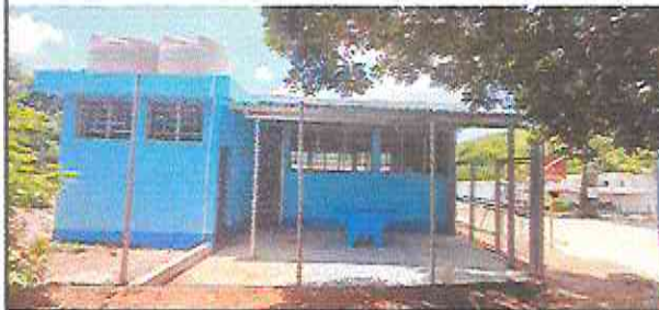
Foto 2: Finalización de circulación perimetral con malla a la altura de 2.5 mts
