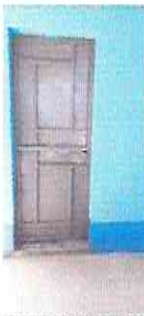
Foto 3: finalización de reparación de puertas.
