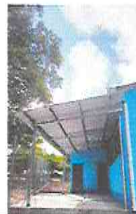
Foto 6: Finalización de galera en área de pila.
