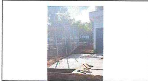
Foto 1: Finalización de torta de cemento en área de pila.
