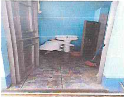
Foto 3: Avance de sustitución de lavamanos
