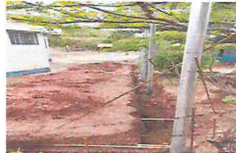
Foto 8: Avance de circulación perimetral con maya
