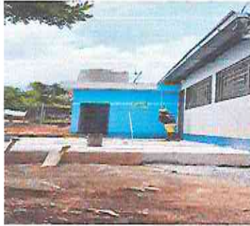
Foto 7: Avance de pintura general
