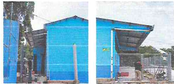
Foto 10: Avance de elaboración de 2 portones
