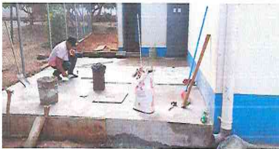
Foto 11: Avance de instalación de piso cerámico en área de pila
