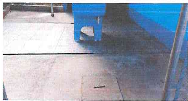
Foto 6: Avance de instalación de pila plástica
