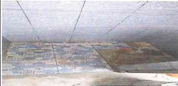
Foto13: Avance de instalación de piso antideslizante en baños
