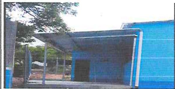
Foto 12: Avance de galera en área de pila
