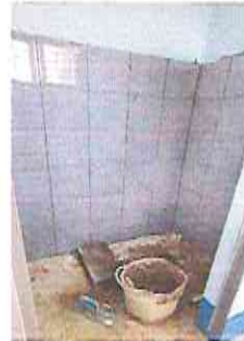
Foto 2: Avance de Azulejo en área de baños
