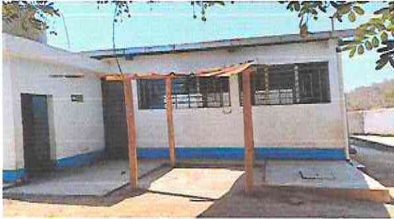
Foto 1: sustitución de torta de cemento
