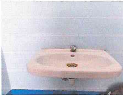
Foto 3: sustitución de lavamanos
