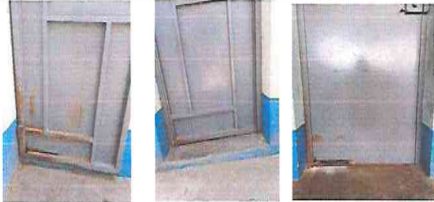
Foto 7: Reparación de puertas
