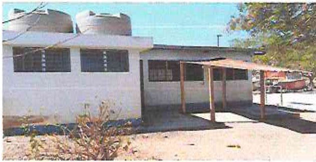
Foto 9: Torta de cemento y Piso cerámico en área de pila
