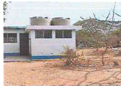
Foto 4: Instalación de tubería al tanque de agua y a los servicios sanitarios
