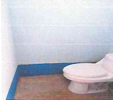
Foto 2: azulejo y piso cerámico en baños
