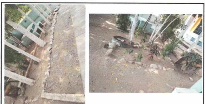
foto No. 6 emparejamiento de patio y colocación de torta de cemento , por estar desanivelado.
