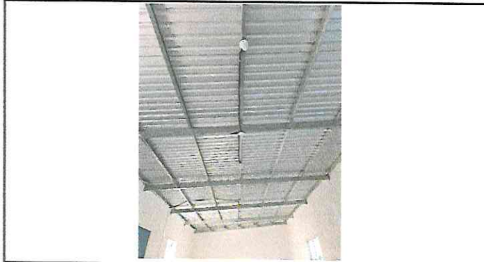
Foto 1: Sustitución de estructura de soporte.
