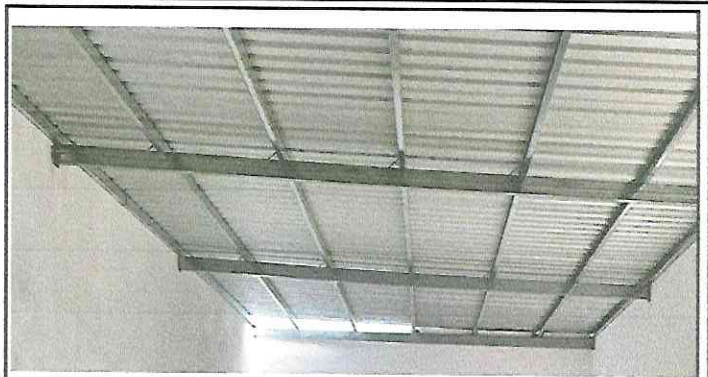
Foto 2: Sustitución de lámina troquelada.
