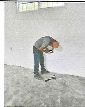
Foto 6: Sustitución del cableado eléctrico.
