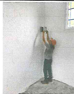
Foto 4: Sustitución de interruptores.
