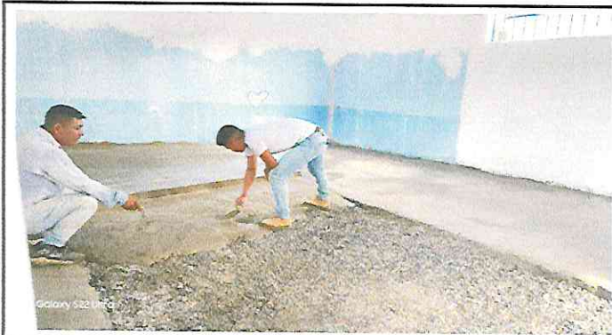
Foto 3: Sustitución de piso de torta de concreto.
