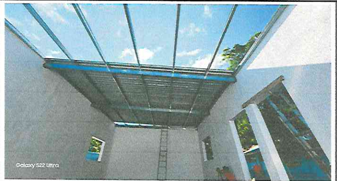
Foto 2: Sustitución de lámina troquelada.
