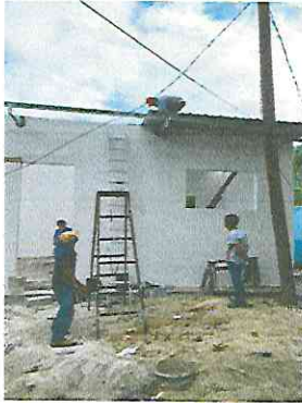
Foto 1: Sustitución de estructura de soporte.
