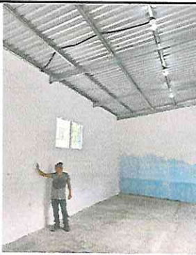
Foto 5: Sustitución de lámparas.
