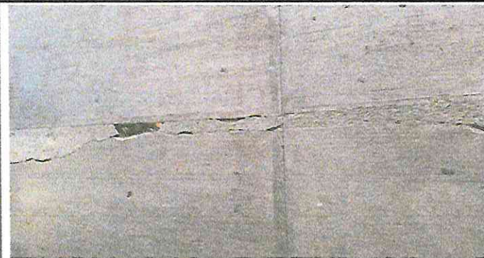
Foto 3: SUSTITUCIÓN DE PISO DE TORTA DE CONCRETO.
