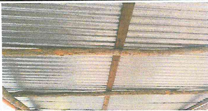
Foto 1: SUSTITUCIÓN DE LÁMINA, POR LÁMINA TROQUELADA ALUZINC CALIBRE 26 CON TORNILLERA DE FIJACIÓN.
