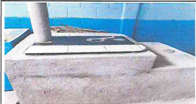
Foto 4: Fundición e instalación de estufa ahorradora con chimenea de concreto.
