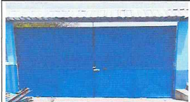
Foto 7: Sustitución de portón de malla por portón de metal con techo.
