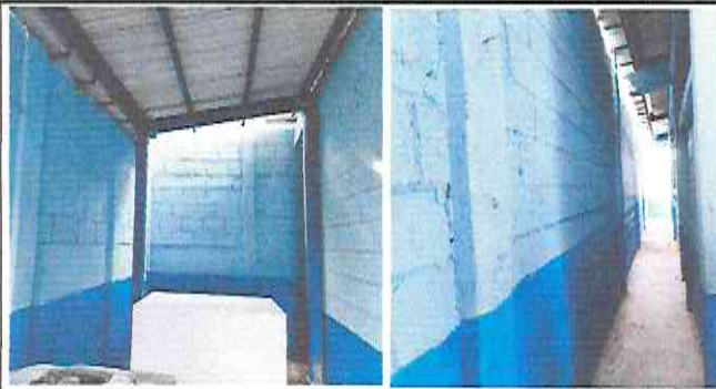
Foto 1: Sustitución de malla por muro de block en área de cocina, el muro abarca parte de atrás de las aulas.
