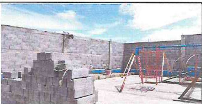
Foto 6: Sustitución de malla por muro de block en área recreativa.
