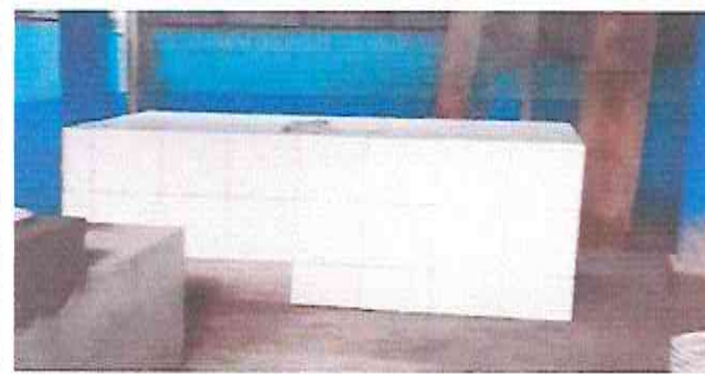
Foto 3: Colocar azulejo en mesa de trabajo.
