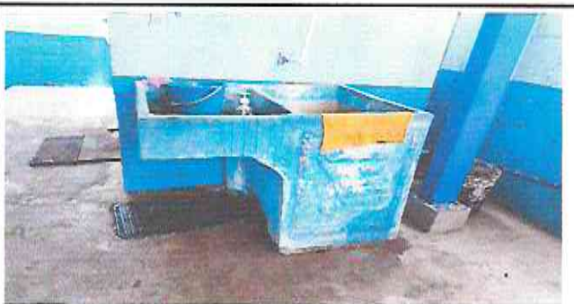
Foto 5: Colocar e instalar pila plástica de dos lavaderos.
