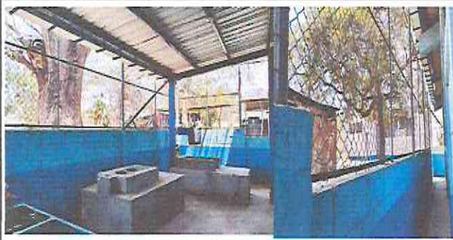
Foto 1: Sustitución de malla por muro de block en área de cocina, el muro abarca parte de atrás de las aulas.
