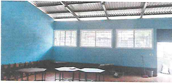
Foto 5: Ventana Pvc suministro de instalación de ventana
