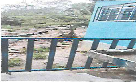
Foto 3: Tubería de agua pvc enterrada y exclusivamente para baños de la escuela
