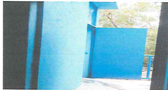
Foto 4: Reparación de puerta de metal
