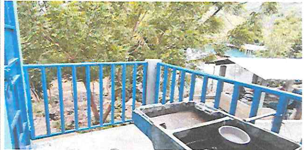
Foto 2: Reforzamiento de baranda (lijar y pintar)
