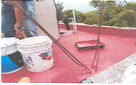
Foto7: Impermeabilización de loza de baños
