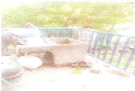
Foto 7. Foto 7.1: Remozamiento de baranda (lijar y pintar)
