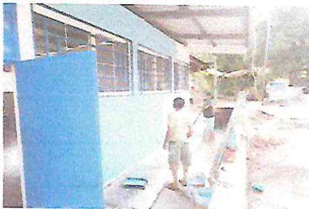
Foto 5. Foto 5.1: suministro y aplicacion de pintura en muros Foto 5.2: pintura general de la escuela
