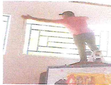
Foto 2. Foto 2.1: ventana de pvc Foto 2.2: suministro de instalacion de instalacion de ventana
