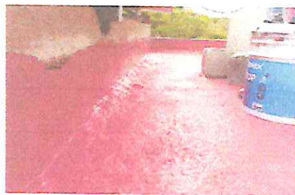
Foto 6. Foto 6.1: Impermeabilizacion de loza de baños
