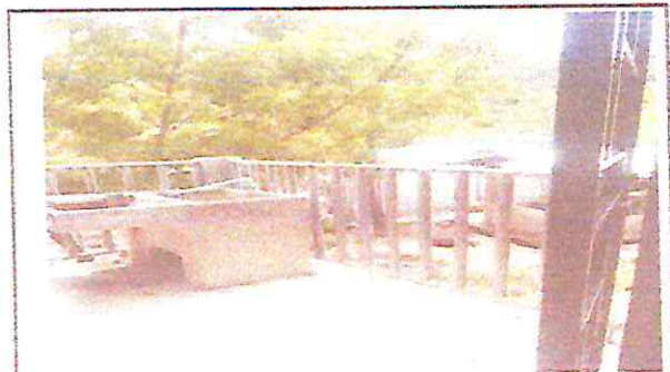
Foto 7. Foto 7.1: Remozamiento de baranda (lijar y pintar)
