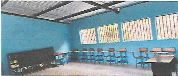
Foto 1: Instalación de piso cerámico en aulas y corredor.
