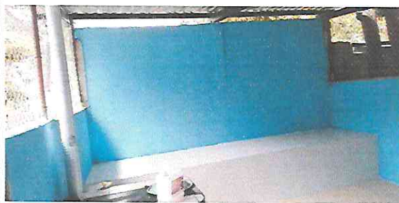
Foto 6: Instalación de azulejo e mesa de trabajo.
