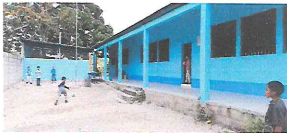
Foto 4: Ampliación de muro en área de cocina
