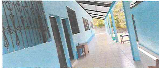
Foto 2: Instalación de piso cerámico en aulas y corredor
