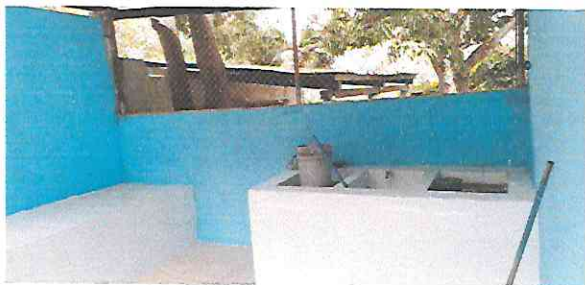
Foto 5: Sustitución de pila
