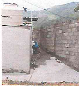
Foto 3: Fundición de banqueta en baños.
