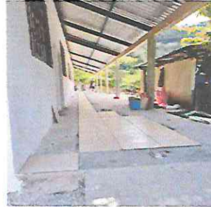
Foto 2: Instalación de piso cerámico en aulas y corredor
