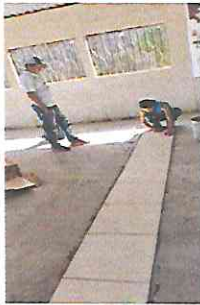
Foto 1: Instalación de piso cerámico en aulas y corredor.
