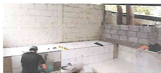
Foto 6: Instalación de azulejo e mesa de trabajo.
