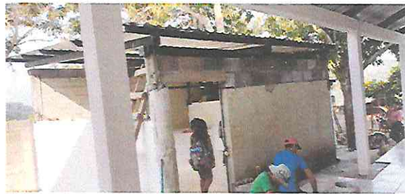
Foto 4: Ampliación de muro en área de cocina
