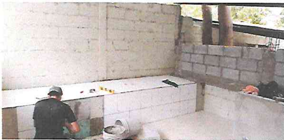
Foto 5: Sustitución de pila
