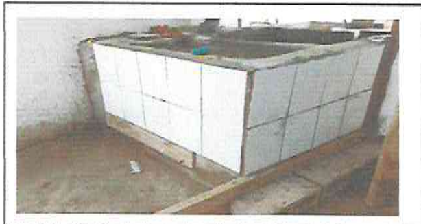
Foto 5: Sustitución de pila y colocación de azulejo
