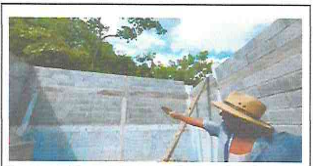
Foto 6: sustitución de maya por block, a lo largo y a un costado de la cocina y bodega.
