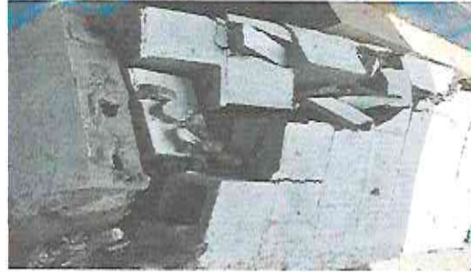
Foto 8: Demolición de baños en mal estado, innecesarios ya que los alumnos ya cuentan con baños nuevos lavables.
