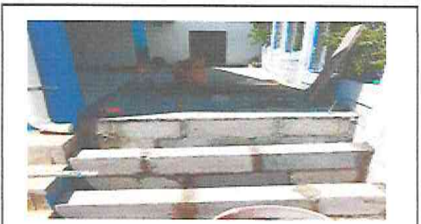
Foto 4: Nivelación y reparación de torta de cemento en corredor.
