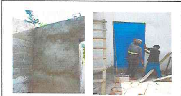
Foto 1: levantado de pared área de cocina y bodega e instalación de puertas.
