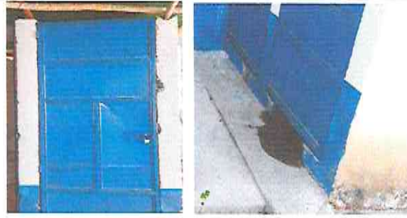
Foto 8: Demolición de baños en mal estado, innecesarios ya que los alumnos ya cuentan con baños nuevos lavables.
