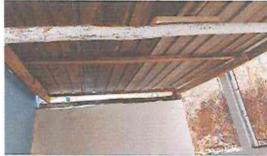
Foto 2: Sustitución de techo en cocina por lamina troquelada y vigas de madera por costaneras.
