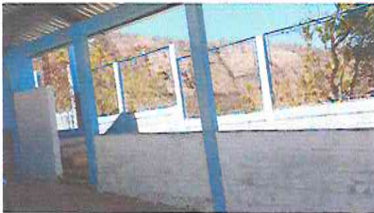
Foto 7: Traslado de balcones de malla para el área de ingreso, serán utilizados los que se quiten de la parte trasera de la cocina, ya que serán sustituidos por block
