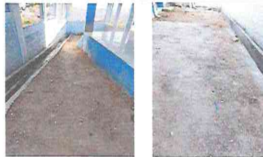
Foto 4: Nivelación y reparación de torta de cemento en corredor.
