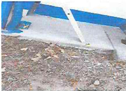
Foto 3: Nivelación y continuidad de torta de cemento en el área de cocina
