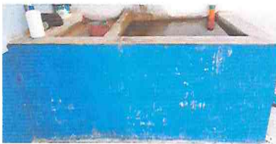
Foto 5: Sustitución de pila y colocación de azulejo
