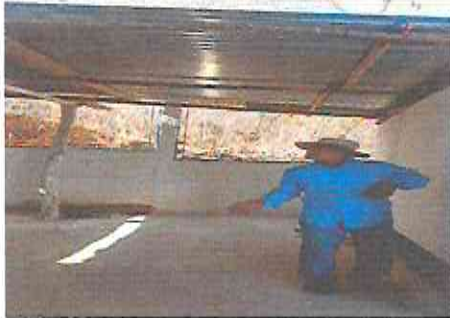
Foto 1: levantado de pared área de cocina y bodega e instalación de puertas.
