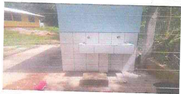
Foto 4: sustitución de pila por lavamanos
