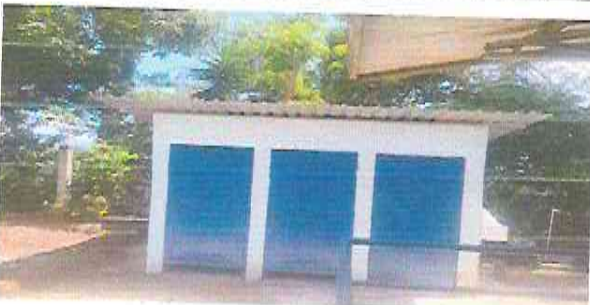
Foto 3: sustitución de baños
