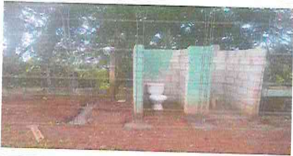
Foto 3: sustitución de baños
