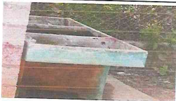
Foto 6: sustitución de pila por lavamanos
