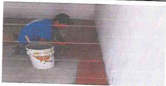
Foto 5: colocación de piso
