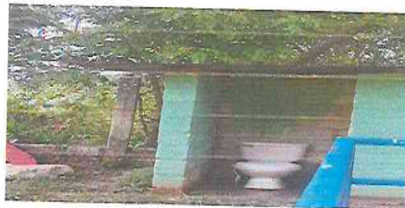
Foto 4: ampieción de baños
