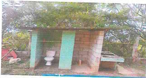
Foto 3: sustitución de baños
