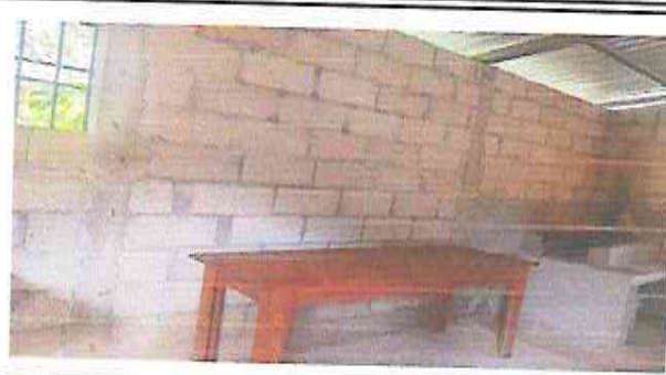
Foto 2: levantamiento de planchón y colocación de azulejo
