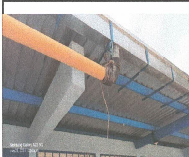
foto 3 mejoramiento de bajada de agua pluvial
