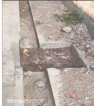
foto 2.mejoramiento de reposadra de concreto con regilla
