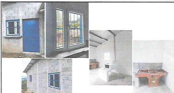
Foto 2: Instalación de balcones de metal, Instalación de ventanas de pvc más vidrio, Instalación de estufa rural (completa) incluye chimenea y plancha de metal, Instalación de pila de concreto de dos lavaderos
