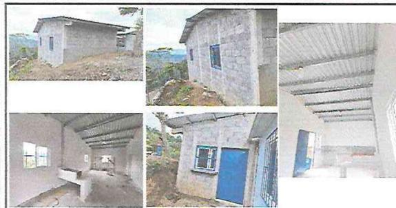
Foto 1: Levantamiento de paredes de block, Fundición de piso de torta de concreto, instalación de estructura de soporte de metal, instalación de lámina troquelada aluzinc calibre 26, instalación de puerta de metal
