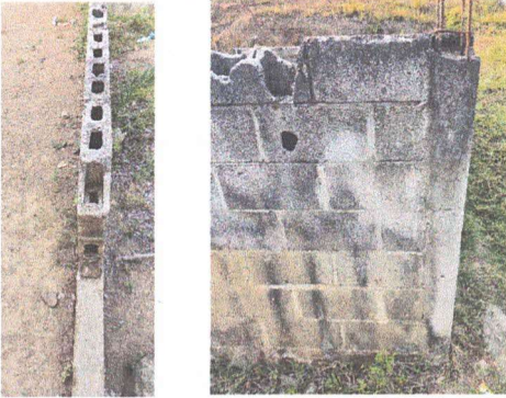
Foto 1: Levantamiento de paredes de block, Fundición de piso de torta de concreto, Instalación de estructura de soporte de metal, Instalación de lámina troquelada aluzinc calibre 26, Instalación de puerta de metal
