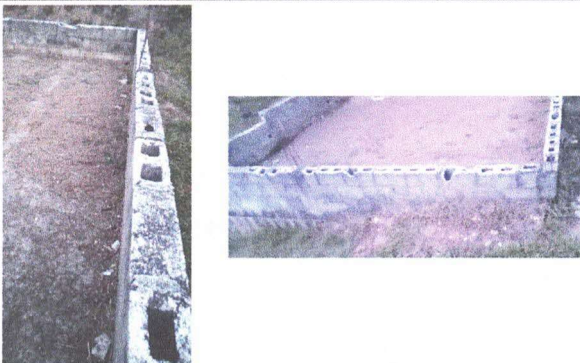
Foto 3: Instalación Tomacorrientes dobles, Instalación Apagadores simples, Instalación Lamparas tipo LED, Fundición de plancha para cocina con muros de block
