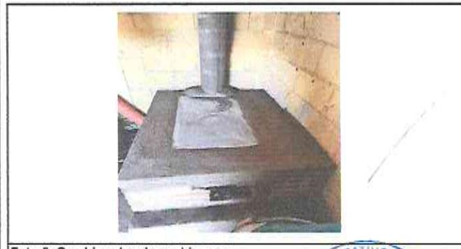
Foto 5: Cambiar plancha y chimenea
