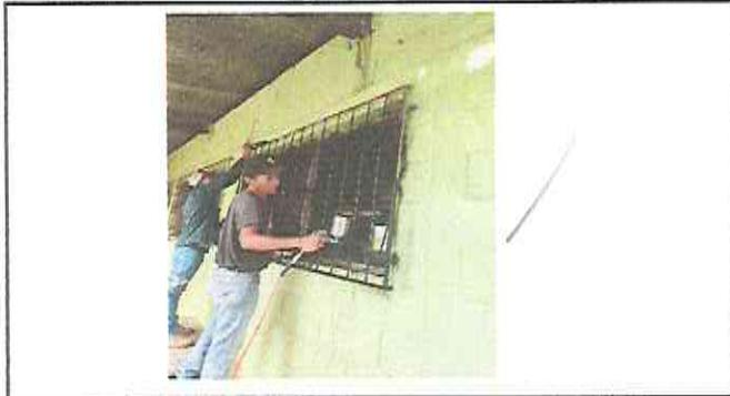
Foto 2: Lijar, limpiar y pintar balcones, cambiar tipo de persiana por ventana de metal corrediza
