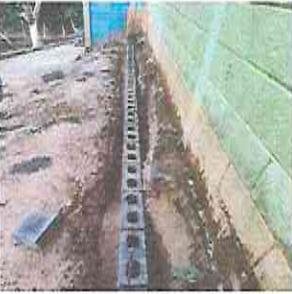
Foto 11: Protección a cimiento patio parte trasera con block fundido
