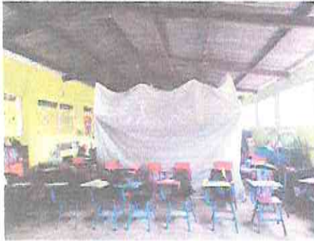
Foto 7: división de salón 4 con madera tratada y plyvoo de 1/2
